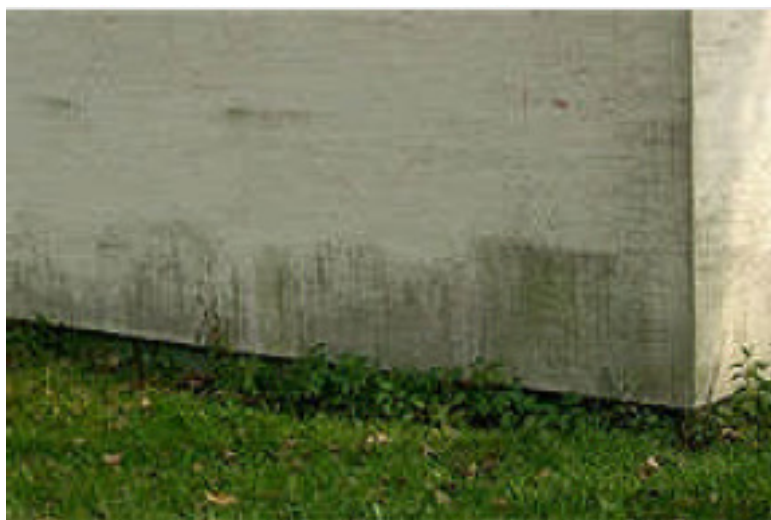
PRESENZA DI ZONE UMIDE NELLA FACCIATA
